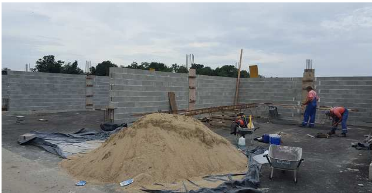
Sl. 25. Izgradnja natkrivenog skladišta za balirani korisni otpad
