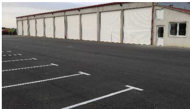
Sl. 14. Garaže u reciklažnom dvorištu
